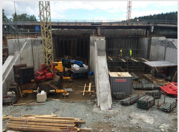
Intagsväggar och form för tak i tubinlopp
