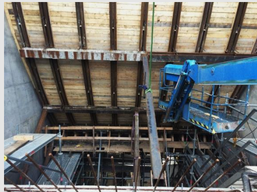
Intagsväggar och form för tak i tubinlopp
