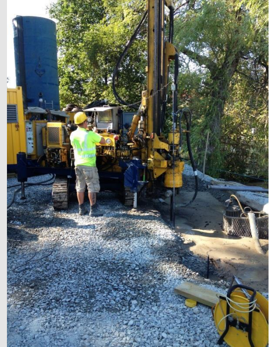
Test av jetpelare- diameter 1m (Keller UE till Veidekke)
