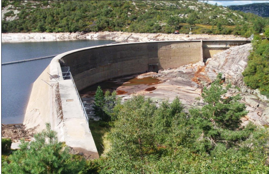
The SKJERKEVATN dam
